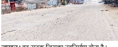
जाखल। वह सड़क जिसका नवनिर्माण होना है।
